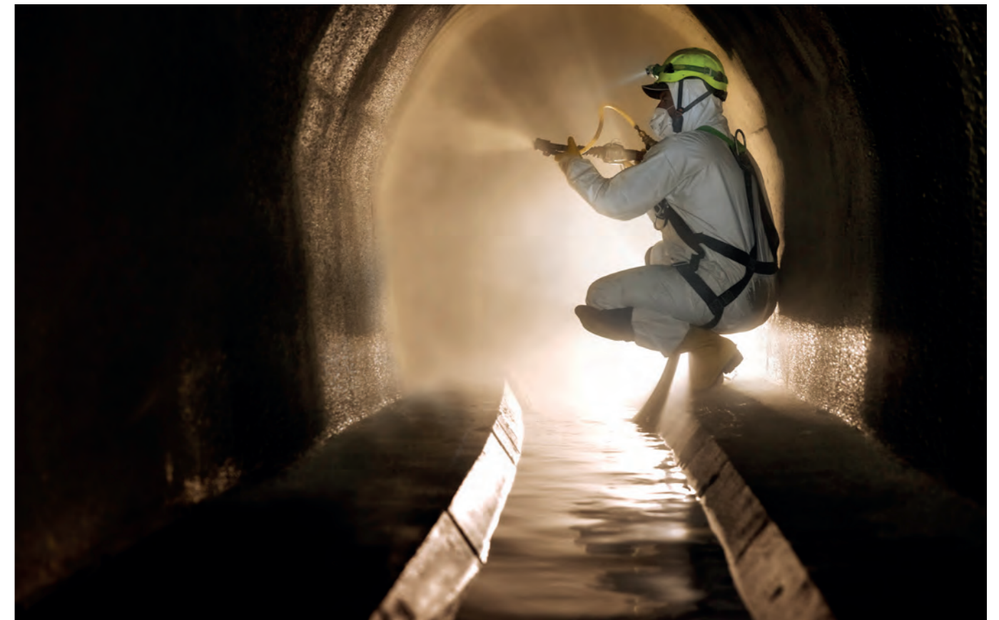
Beschichtung im Nassspritzverfahren
