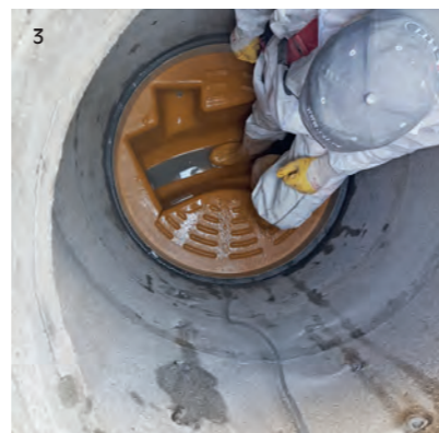
1, 2, 3 Einbau des sogenannten Flex-Liners zur Sanierung eines defekten Schachtgerinnes
