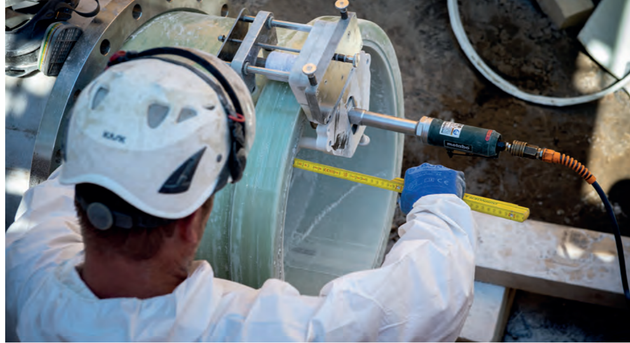
Einbau eines glasfaserverstärkten Epoxidharzflansches
