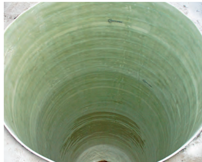
Mit UV-Licht ausgehärteter GFK-Schachtliner
