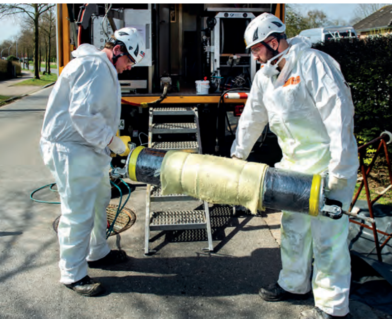
Harzgetränkter Kurzliner auf Versetzpacker vor Einbringung ins Altrrohr
