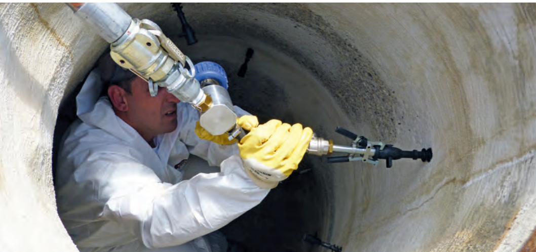
Durchführung einer Injektion im Schacht
