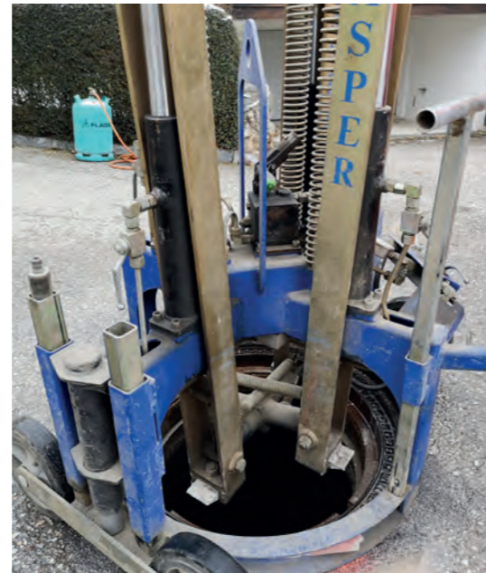
Neu-Positionierung eines Schachtrahmens
