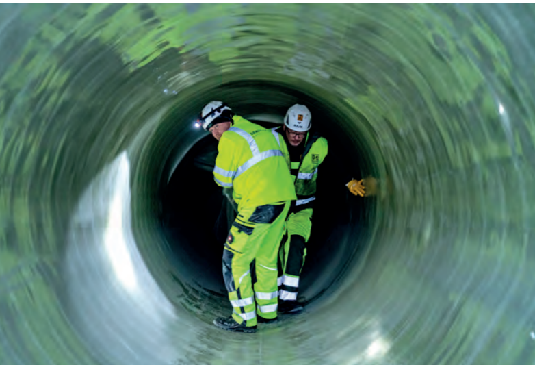
Mittels UV-Licht-Technologie ausgehärteter GFK-Liner
