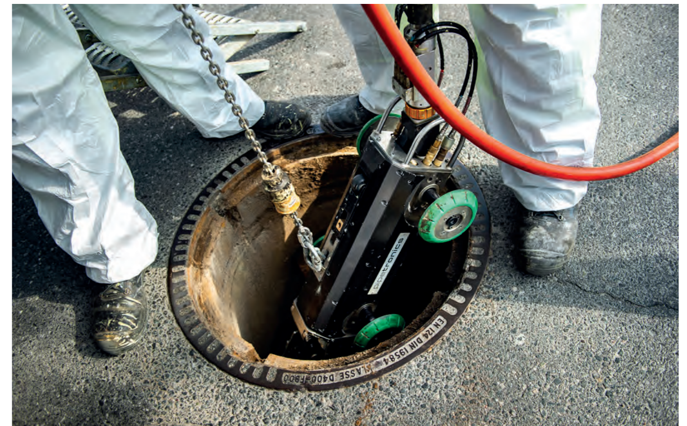
Einbringen des Roboters zur Durchführung von Reparaturarbeiten
