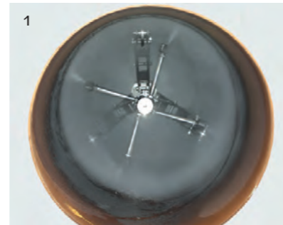
1 Rohrquerschnitt mit Rotierdüse 2 Reinigungskopf vor Einbringung ins Rohr 3 Mobile Höchstdruckreinigungsanlage
