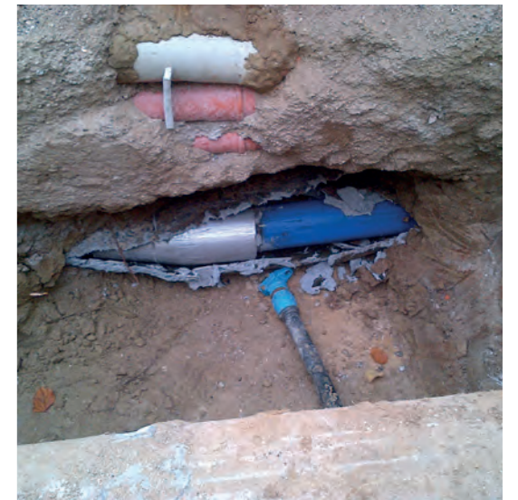
Ersetzen einer AZ-Trinkwasserleitung mittels Berstlining
