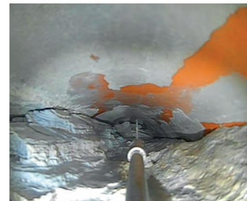
Rohrleitung vor und nach der Drain-Jet-Reinigung
