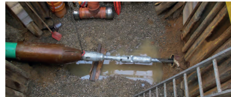
Einbringen des Berstwerkzeuges (Berstkopf mit Berstgestänge)
