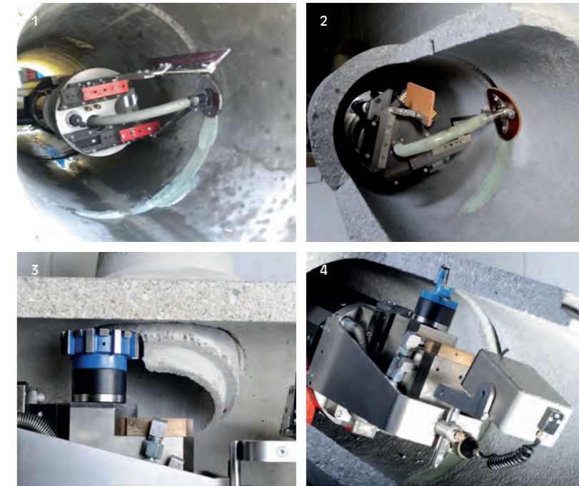
1+2 Verspachteln von Rissen 3+4 Einsatz eines Fräsroboters
