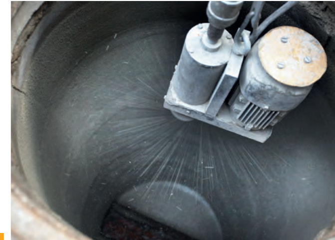
Schachtbeschichtung im Anschleuderverfahren
