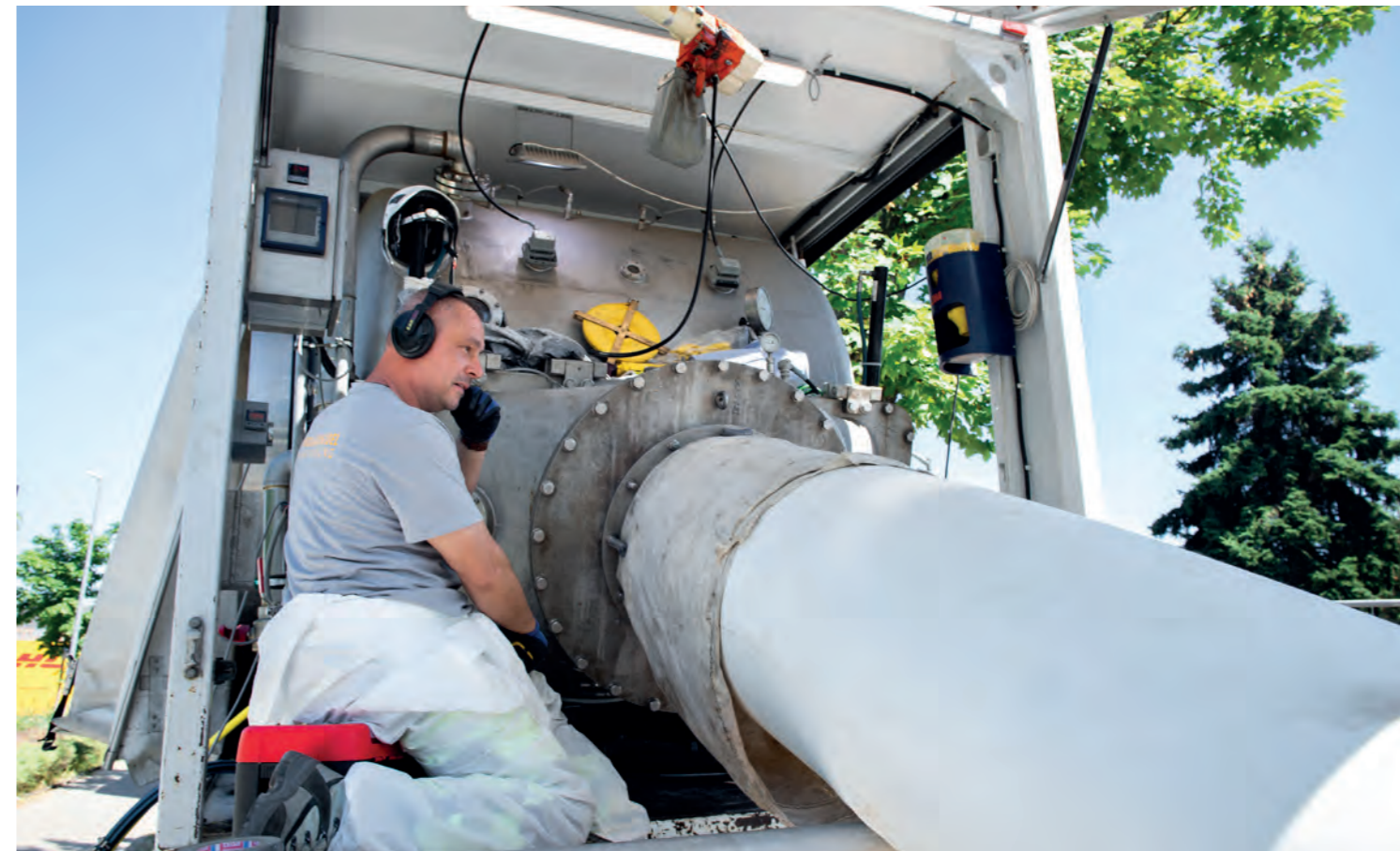
Inversion des Liners mittels Drucktrommel
